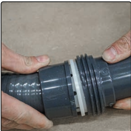
Schlauch einschieben
