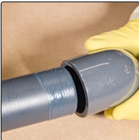
Bauteile verbinden (viertel Drehbewegung)
