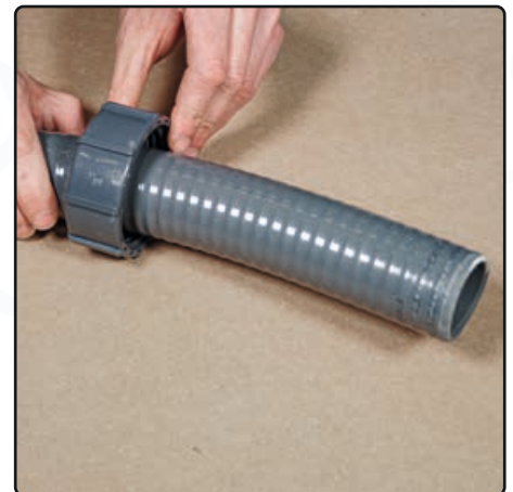
Überwurfmutter aufziehen
