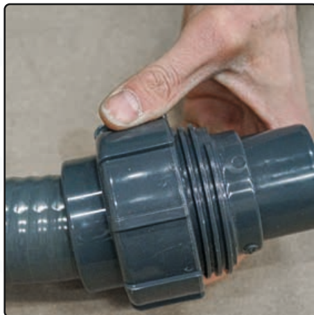
Überwurfmutter ansetzen und verschrauben
