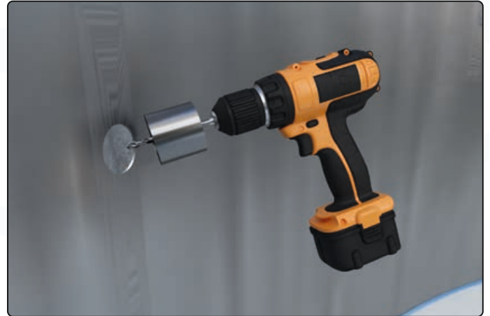
Loch anzeichnen und bohren
