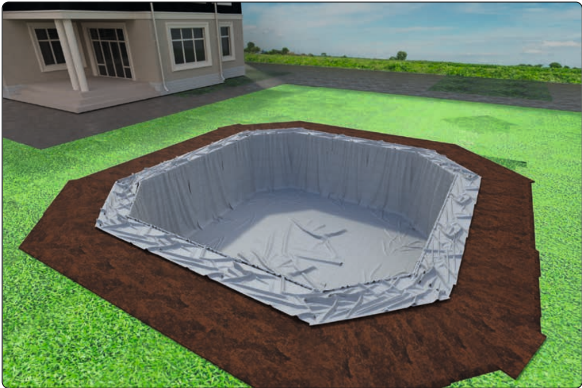
Geotextvlies vollflächig ausgelegt
