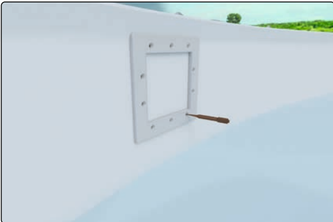
Lochbild nach dem Innenflansch anzeichnen und vorstechen
