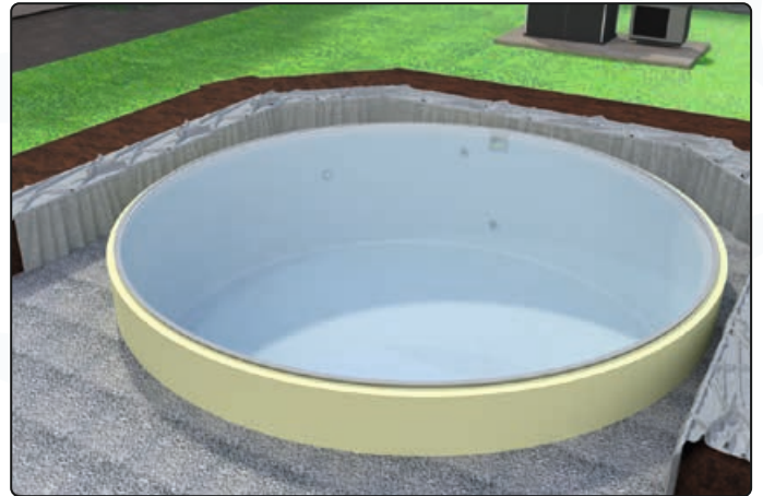
Kies gleichmäßig in der Baugrube einbringen
