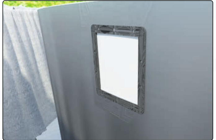
Doppeldichtung auf die Rückseite der Skimmeröffnung stecken
