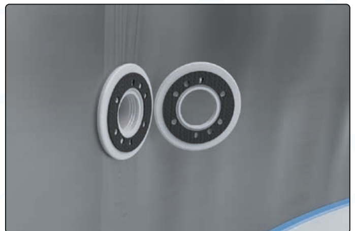
Kleben Sie die Dichtungsscheiben auf
