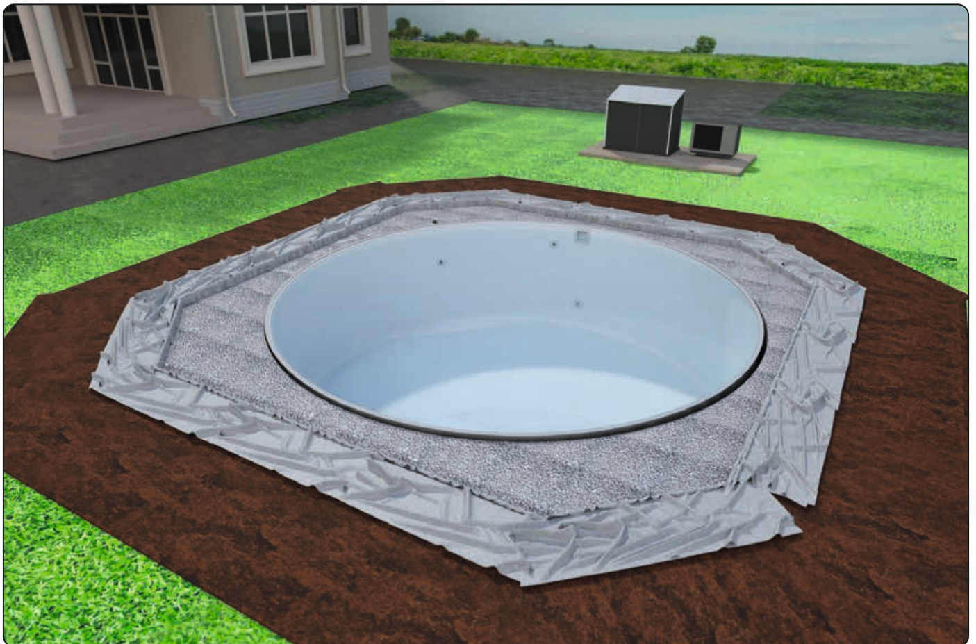
Baugrube gleichmäßig mit Kies aufgefüllt
