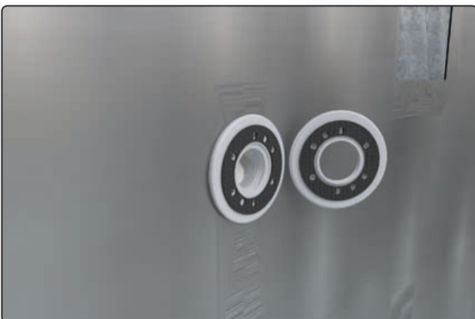
Kleben Sie die Dichtungsscheiben auf
