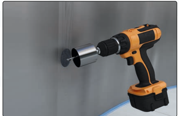
Loch anzeichnen und bohren
