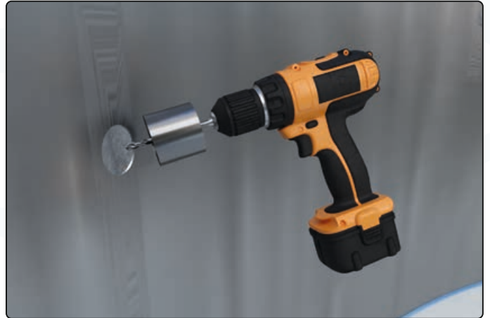
Loch anzeichnen und bohren
