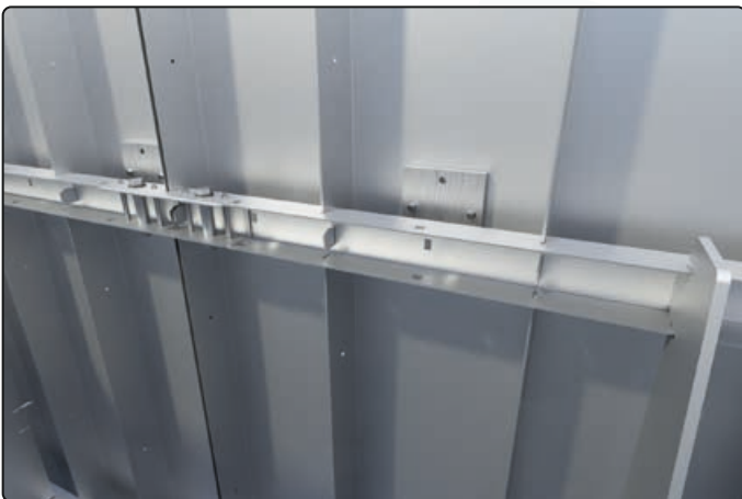
Flansche mit Schrauben durch die Löcher stecken
