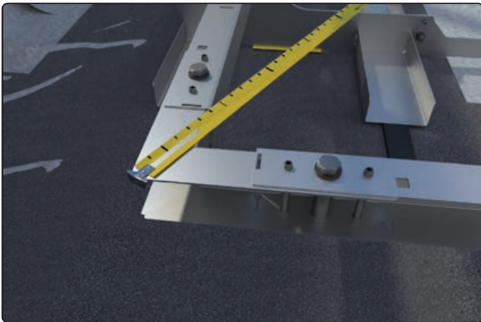
Die Diagonalen werden an den Eckverbindern unten und oben gemessen
