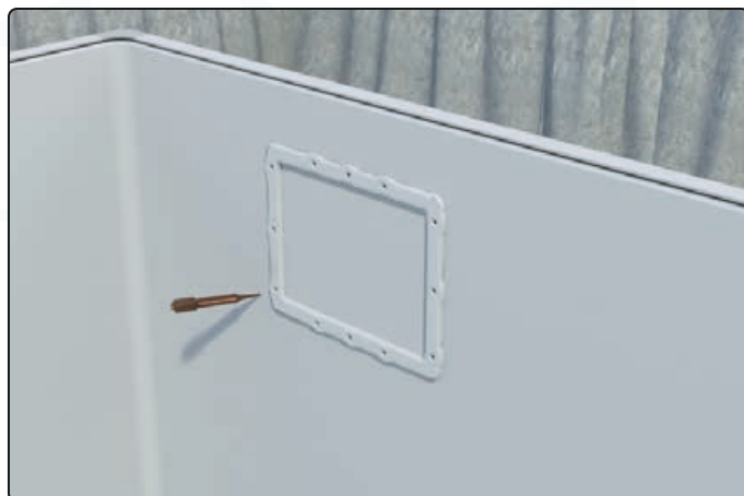
Lochbild nach dem Innenflansch anzeichnen und vorstechen
