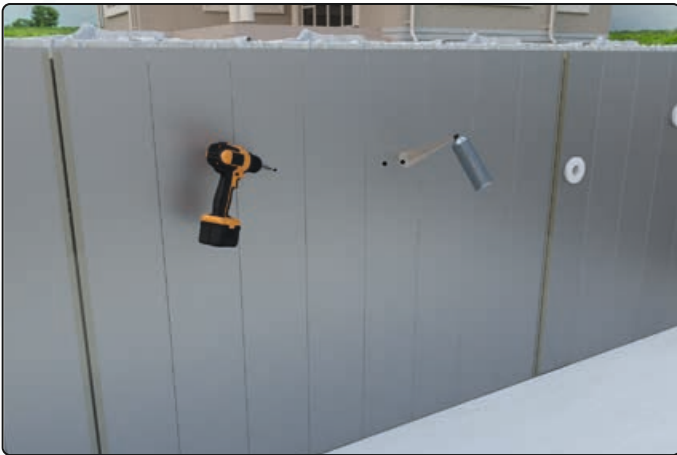
Bohren und verzinken
