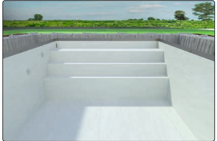
Die Treppe wird vollflächig mit Softtouch beklebt
