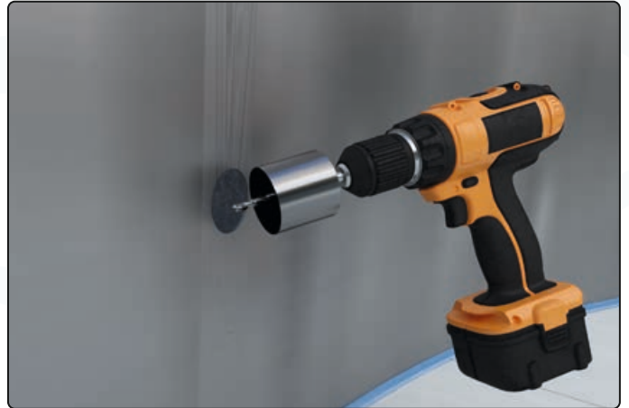
Loch anzeichnen und bohren
