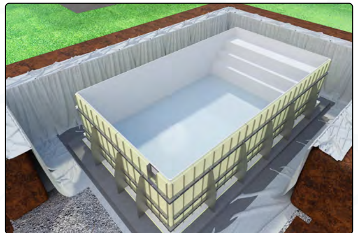
Füllen Sie etwa 3 mm Wasser in den Pool und glätten Sie die Bodenfallen
