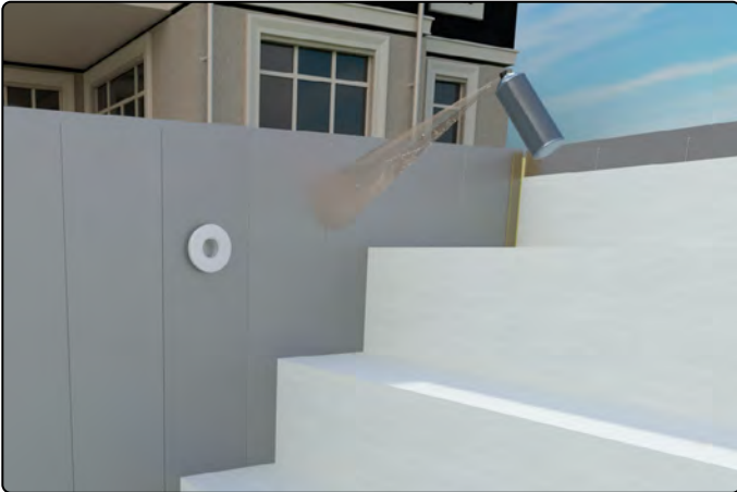
U-Bleche mit Sprühkleber einsprühen und Softtouch an die Wand drücken
