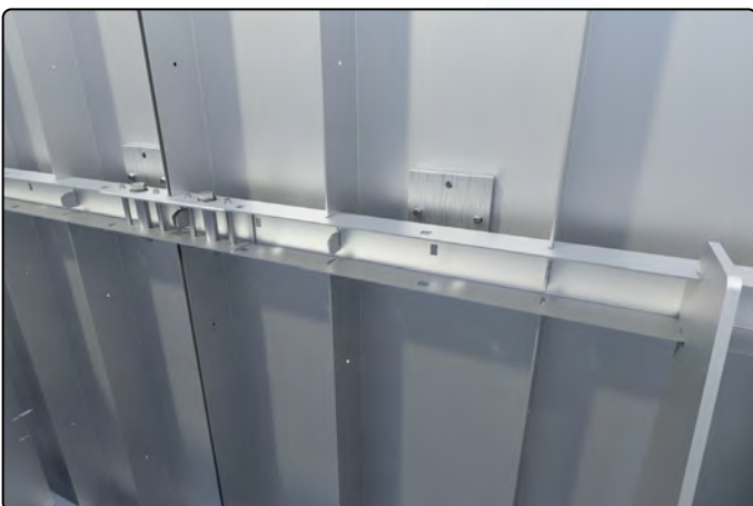
Flansche mit Schrauben durch die Löcher stecken
