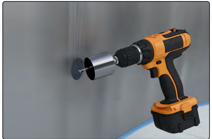
Loch anzeichnen und bohren
