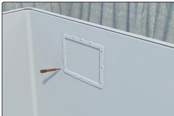
Lochbild nach dem Innenflansch anzeichnen und vorstechen
