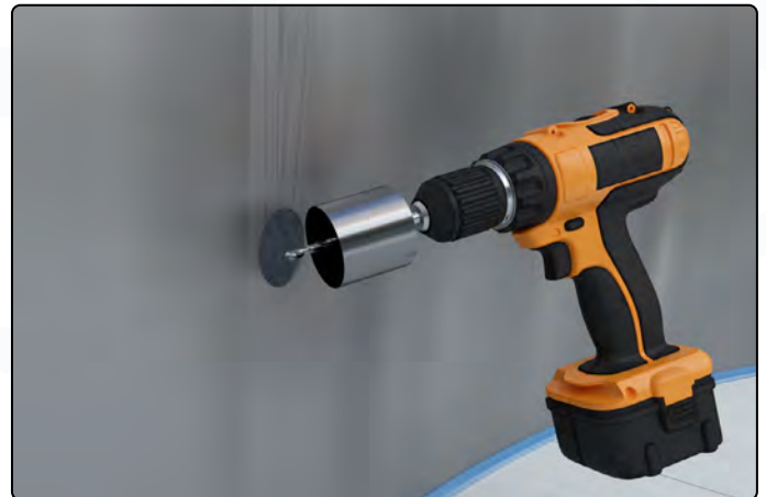
Loch anzeichnen und bohren
