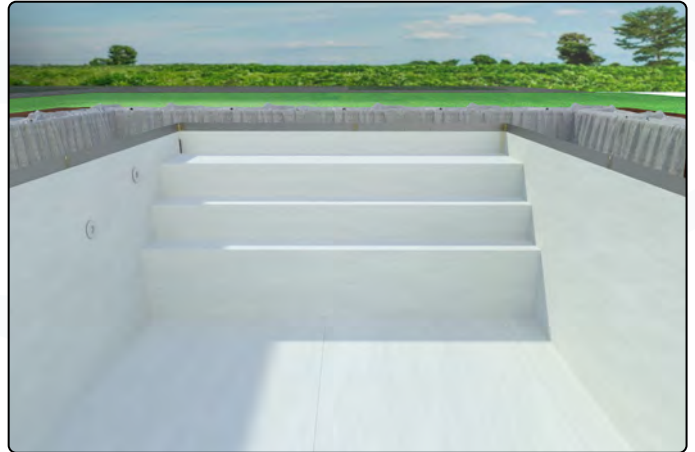
Die Treppe wird vollflächig mit Softtouch beklebt
