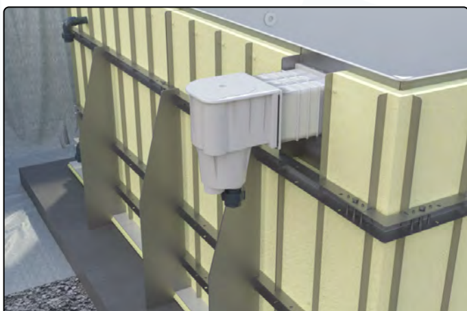
Skimmer mit der Verlängerung ansetzen
