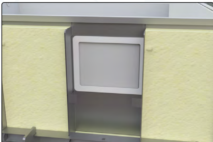
Doppeldichtung auf die Rückseite der Skimmeröffnung stecken
