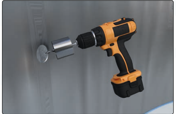
Loch anzeichnen und bohren
