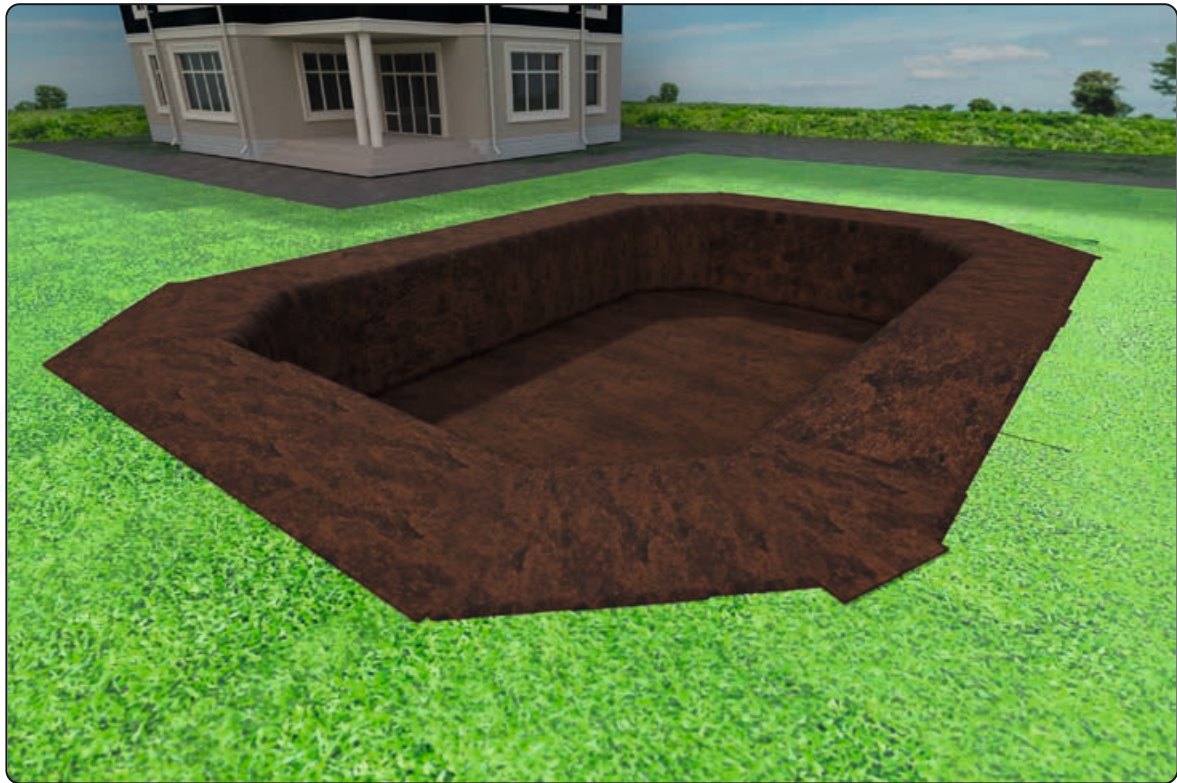
Beispiel 1: Die Baugrube wurde ausgehoben, der Untergrund ist bereits tragfähig
