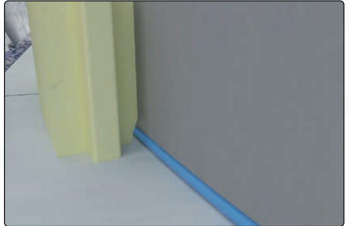
Die Rundschalung sollte an der Bodenschiene um 45° angeschragt werden
