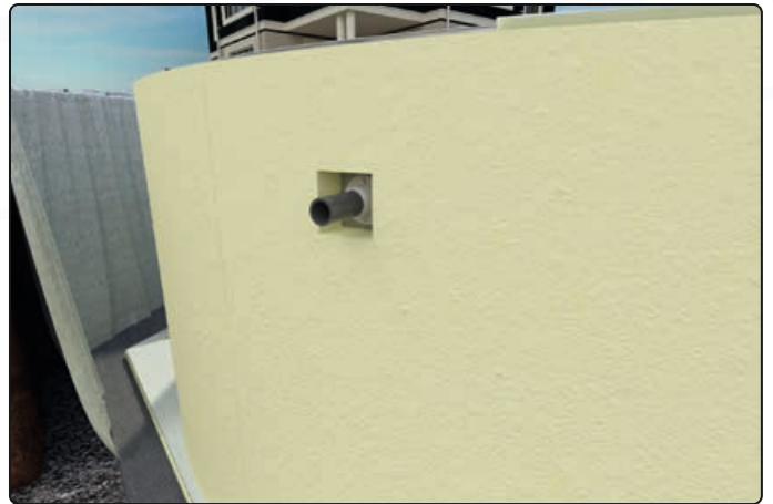
Die Einbauteile sollten aus den Rundschalungselementen ausgeschnitten werden
