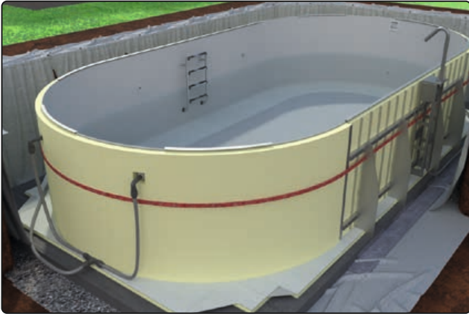
Becken bis auf 60 cm Höhe befüllen
