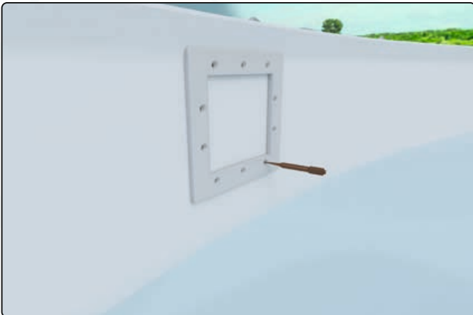
Lochbild nach dem Innenflansch anzeichnen und vorstechen
