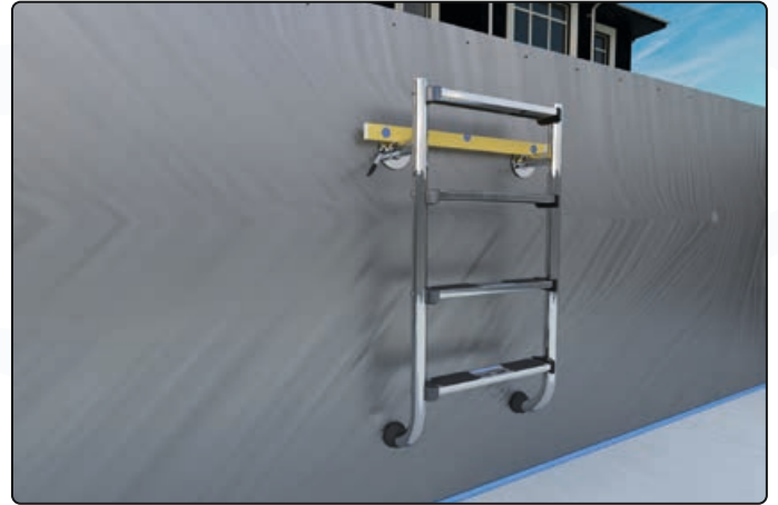
Im Becken positionieren und kennzeichnen
