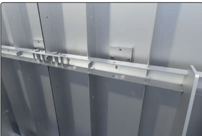
Flansche mit Schrauben durch die Löcher stecken
