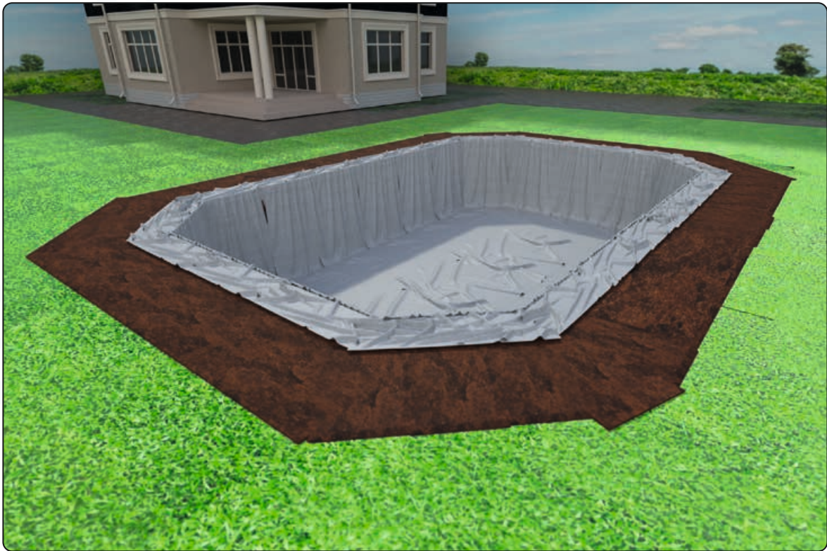
Geotextvlies vollflächig ausgelegt
