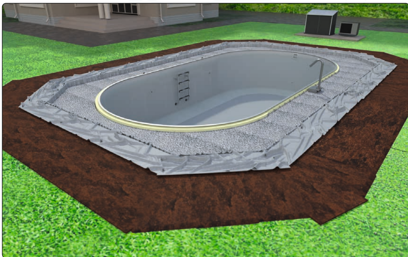
Baugrube gleichmäßig mit Kies aufgefüllt
