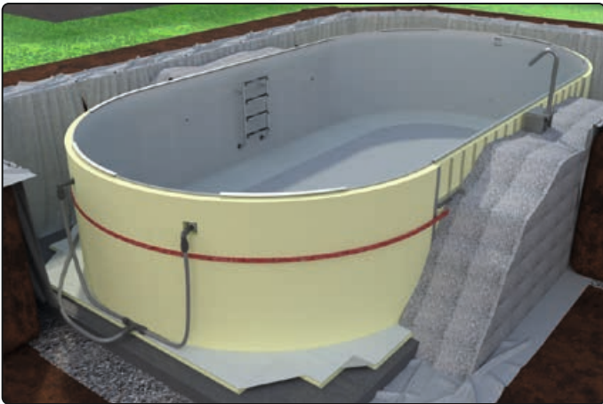
Wasser und Kies hinter den Stützwänden parallel füllen
