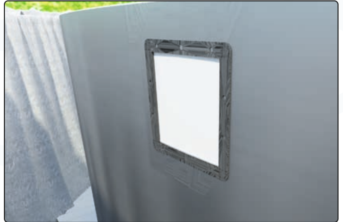
Doppeldichtung auf die Rückseite der Skimmeröffnung stecken
