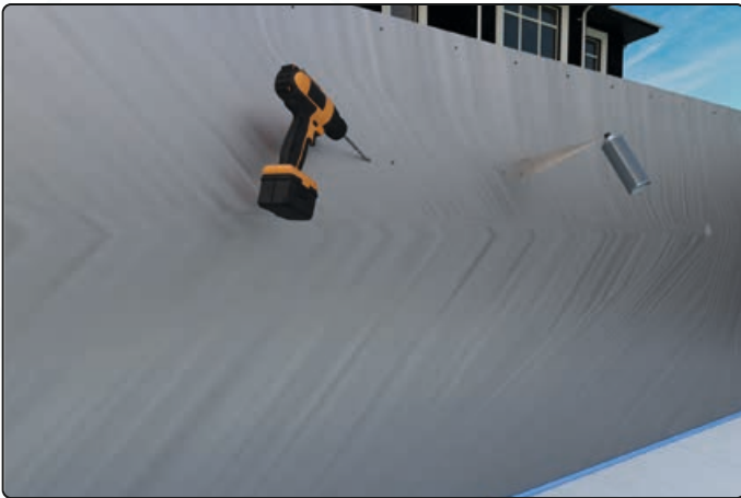
Bohren und verzinken
