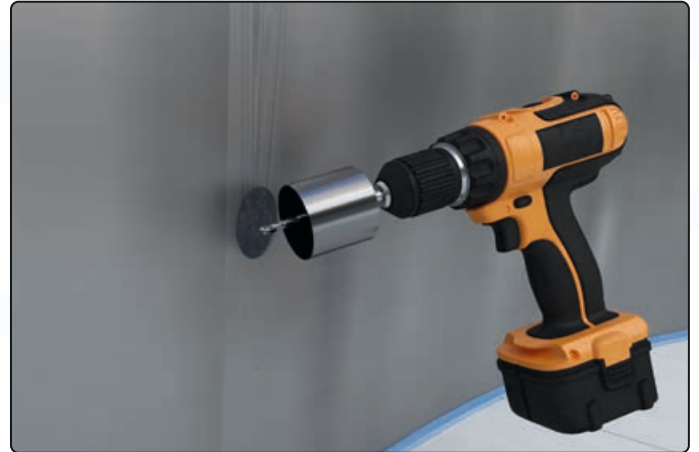
Loch anzeichnen und bohren
