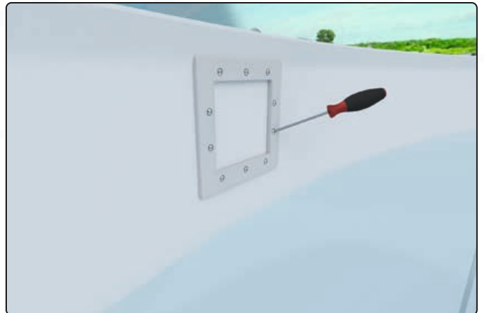
Innenflansch anschrauben
