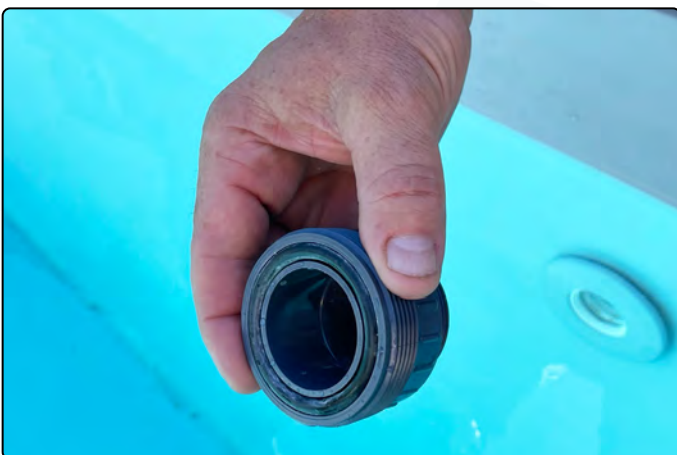
Verschraubung in die oberste Einlaufdüse schrauben
