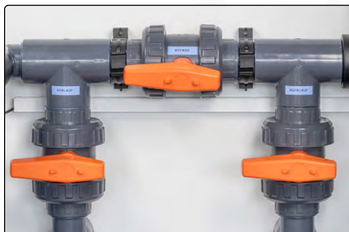
Bypass öffnen / Vor- und Rücklauf schließen
