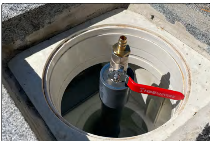
Ausblasvorrichtung in Skimmer stecken
