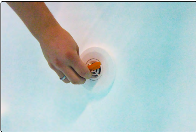
Kugel / Gewinding oder Schutzgitter entfernen
