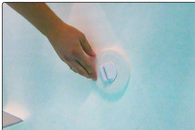
restliche Düsen mit Winterverschlusskappe verschließen
