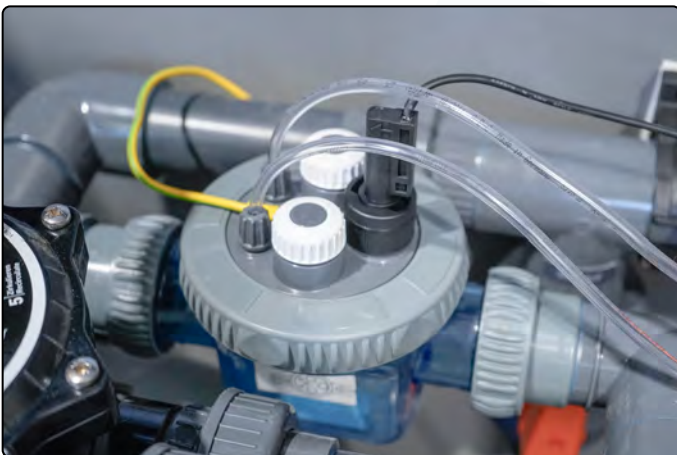
Verschlussstopfen entfernen
