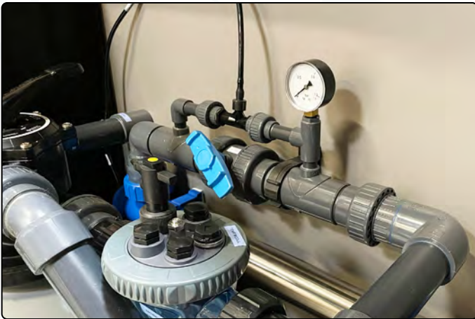
Druckveränderung AOP durch blauen Hahn
