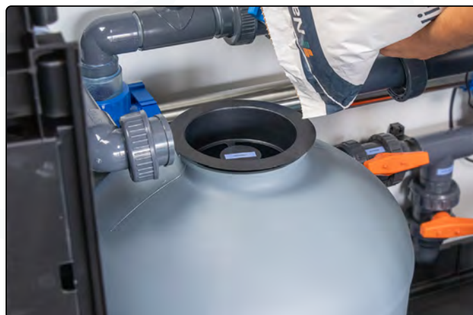
Filtermaterial einfüllen
