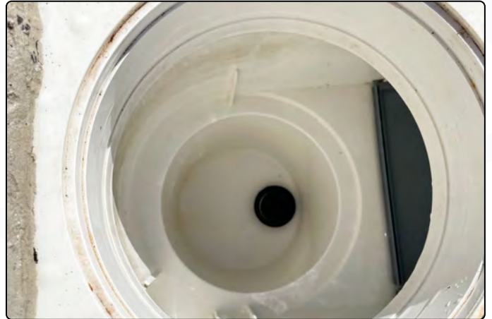
Skimmer mit Winterverschlussstopfen verschließen
