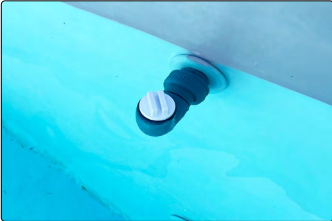
Winterverschlusskappe auf den Winkel schrauben
